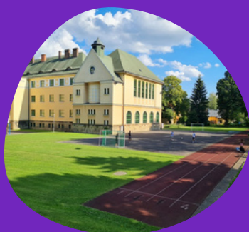
Oprava hřiště gymnázia
