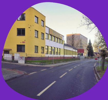
Rekonstrukce ulice Kubelkova
